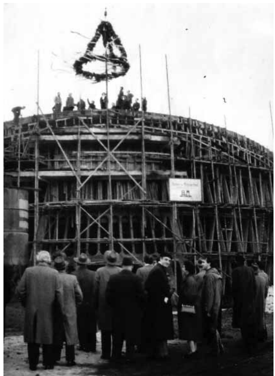
Richtfest am Feierabendhaus.
