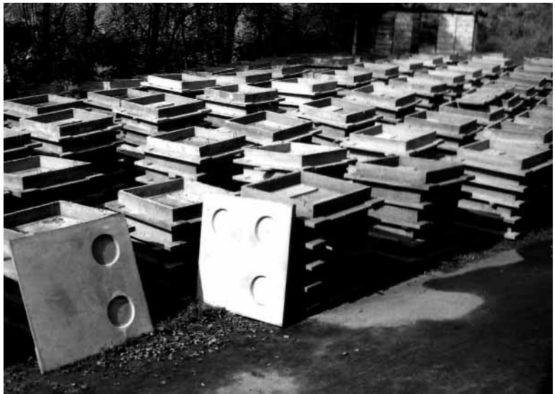
Die Dachplatten wurden vor Ort gegossen und dann einzeln verlegt.
