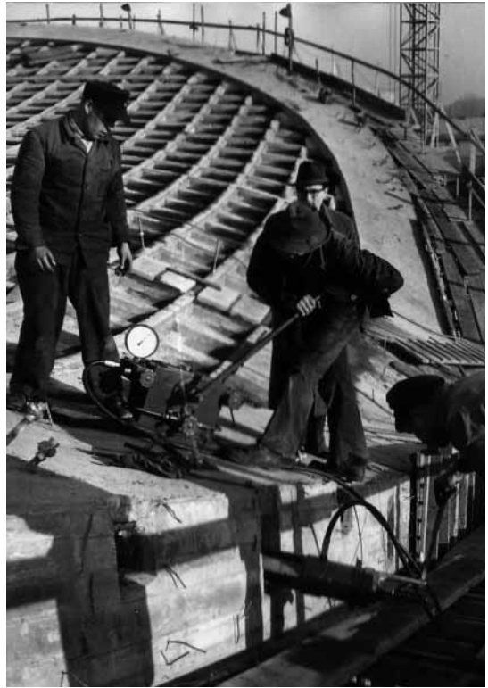
Das frei aufliegendem Schalendach trägt sich ohne zusätzliche Innenstützen. Dazu mussten die Stahlstreben gespannt werden.
