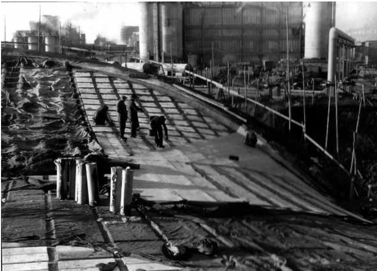
Die Dachplatten wurden vor Ort gegossen und dann einzeln verlegt.
