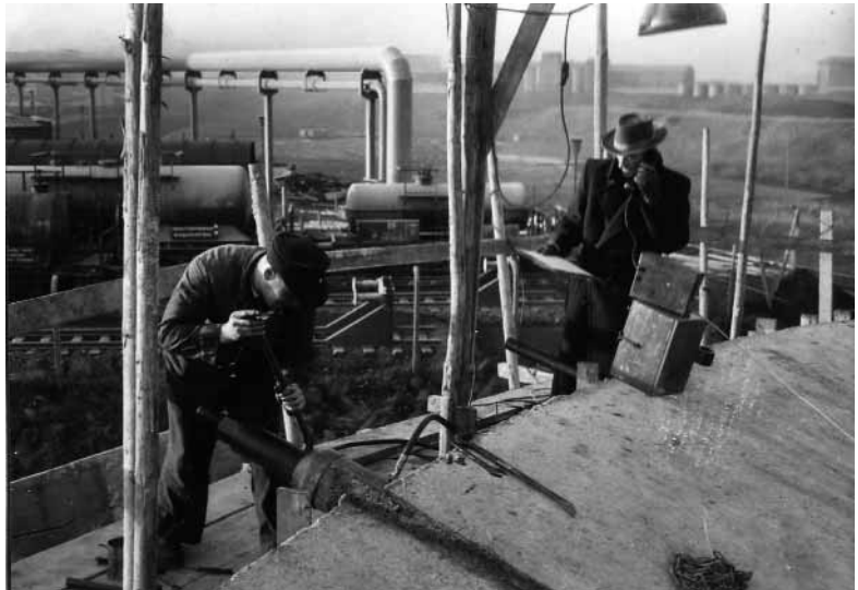
Das frei aufliegendem Schalendach trägt sich ohne zusätzliche Innenstützen. Dazu mussten die Stahlstreben gespannt werden.
