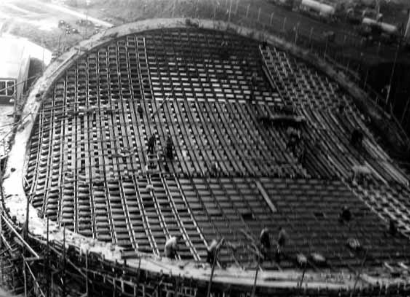
Die spektakuläre Dachkonstruktion!
